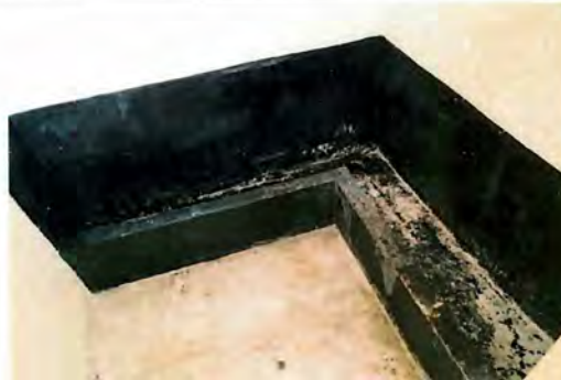
Foto 12: Instalación de Reposaderas
