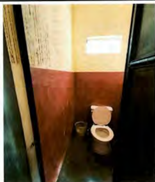
Foto 9: Sustitución de azulejo (en sanitarios)
