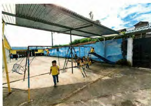
Foto 8: Pintura en muros exteriores e interiores
